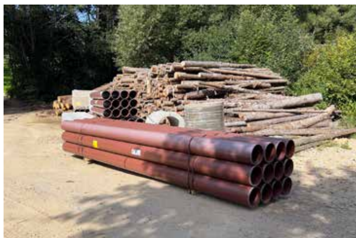
Insgesamt rund 2,5 km lang ist der neue Mischwasserkanal zwischen der Ortschaft March und der Kläranlage Regen. Zum Einsatz kommt dabei das HS®-Kanalrohrsystem von Funke Kunststoffe.
