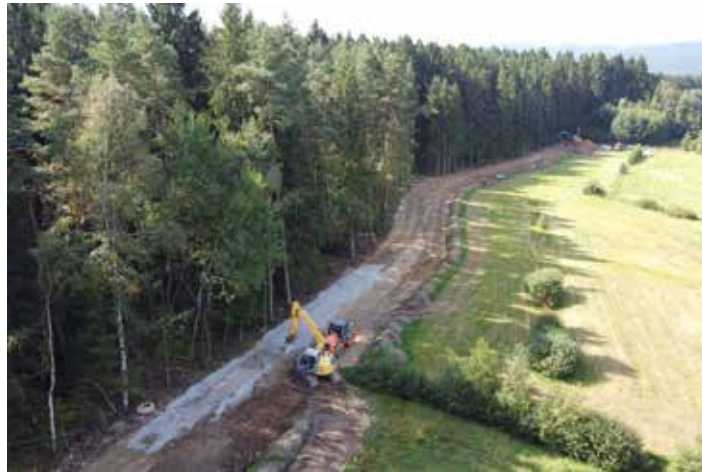
Eine Baustelle wie im Bilderbuch – wenn man die Lage am Rand des Nationalparks Bayerischer Wald betrachtet. Bei der Verlegung hatten die Tiefbauer allerdings mit schwierigen Bodenverhältnissen zu kämpfen.
