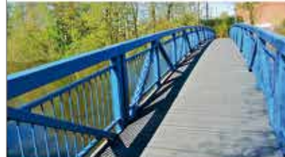
TRIMAX® als Brückenbelag
