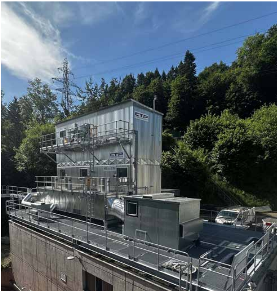
Die ara region bern AG setzt seit 2025 auf CTP-Technologie, um ihre Lachgasemissionen aus der biologischen Reinigungsstufe und der Faulwasserbehandlung effektiv zu reduzieren.
