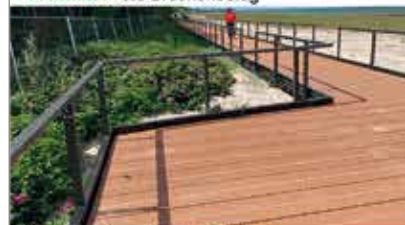
Steg am Strand aus TRIMAX®
