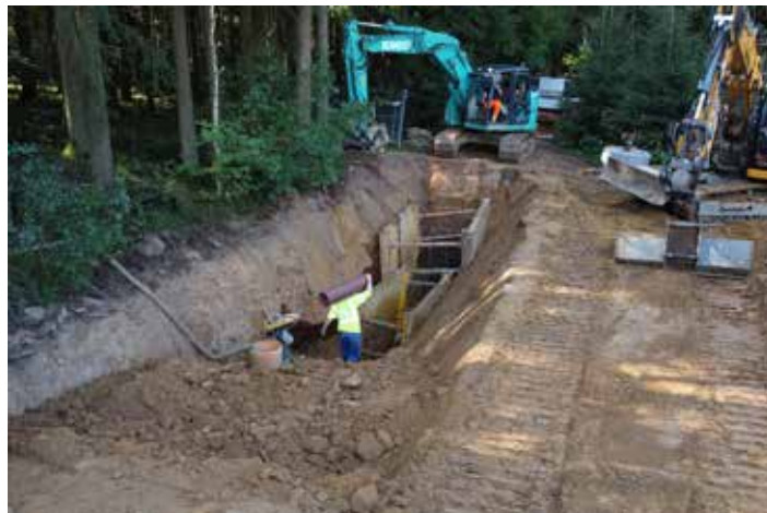
Die Sohltiefe des neuen Schmutzwasserkanals variiert auf der Baustrecke deutlich und beträgt 1,20 m bis maximal 5,0 m. Hier überzeugten die HS®-Kanalrohre durch ihre flexiblen Baulängen.
